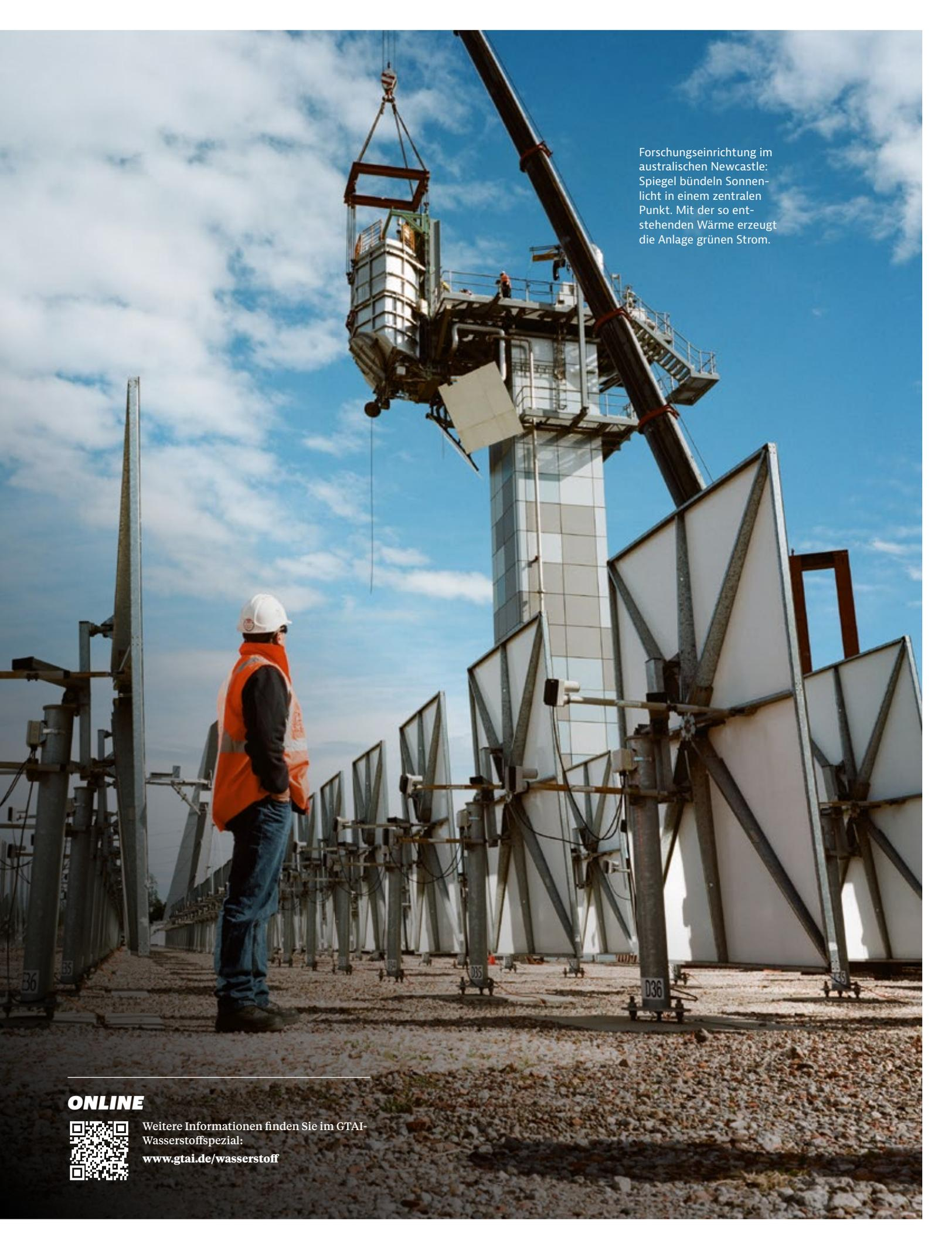
Forschungseinrichtung im australischen Newcastle: Spiegel bündeln Sonnenlicht in einem zentralen Punkt. Mit der so entstehenden Wärme erzeugt die Anlage grünen Strom.
