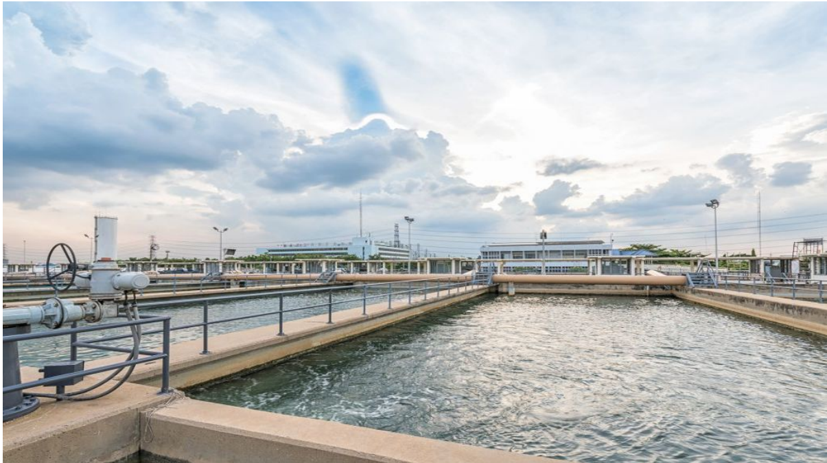
Wasseraufbereitungsanlage | © tuachanwatthana - iStock.com
