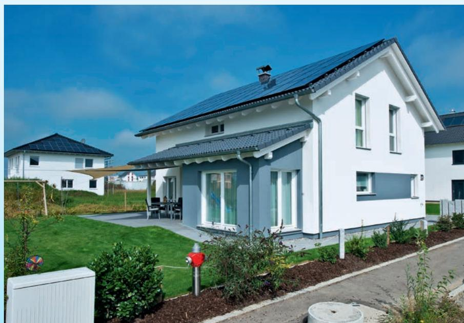
WeberHaus社の標準型プラスエネルギー・プレハブハウスは、太陽光発電とヒートポンプシステムで必要量より90%多いエネルギーを生産する。この結果、温水と暖房の費用が毎月10ユーロ以下ですむ
