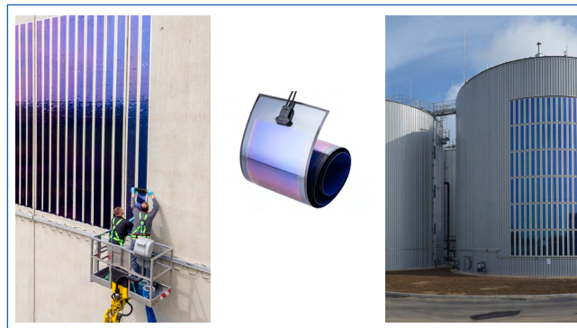
HeliaSol® - organische Solarfolien / Bilder v.l.n.r. innogy, Heliatek, RWE
