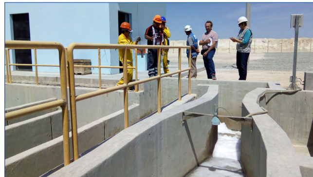
Kläranlage in El Pedregal, Peru / Foto: Sachsen Wasser GmbH
