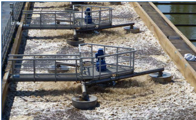
BSK®-Turbinen auf Schwimmsystemen / Foto: Biogest International® GmbH
