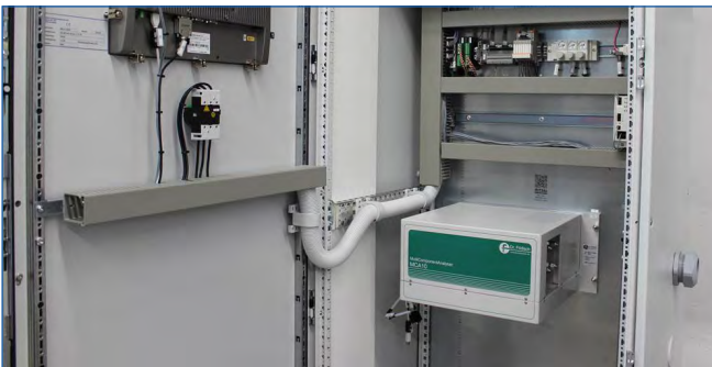
Foto: MCA 10 der Dr. Födisch Umweltmesstechnik AG integriert in einem Systemschrank
